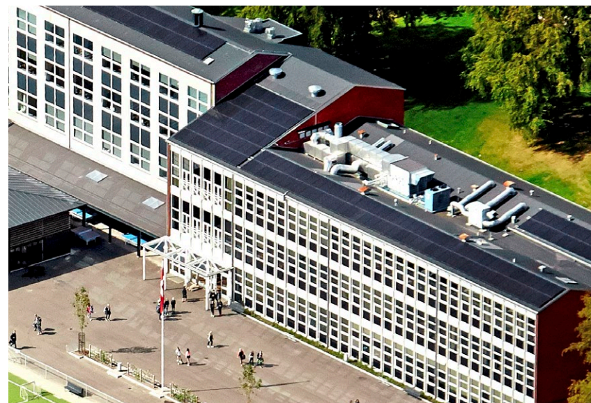
Luftfoto af det, vi kalder bygning C, viser tydeligt det rørsystem, der er en del af skolens klimaanlæg. Udover held er et godt indeklima og sunde bygninger måske en del af forklaringen på, at vi i lang tid undgik smittetilfælde.
