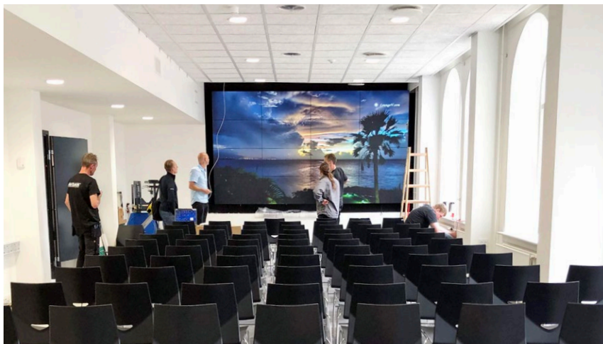
Der lægges sidste hånd på det store auditorium i de nye bygninger, Fabersvej 1.
